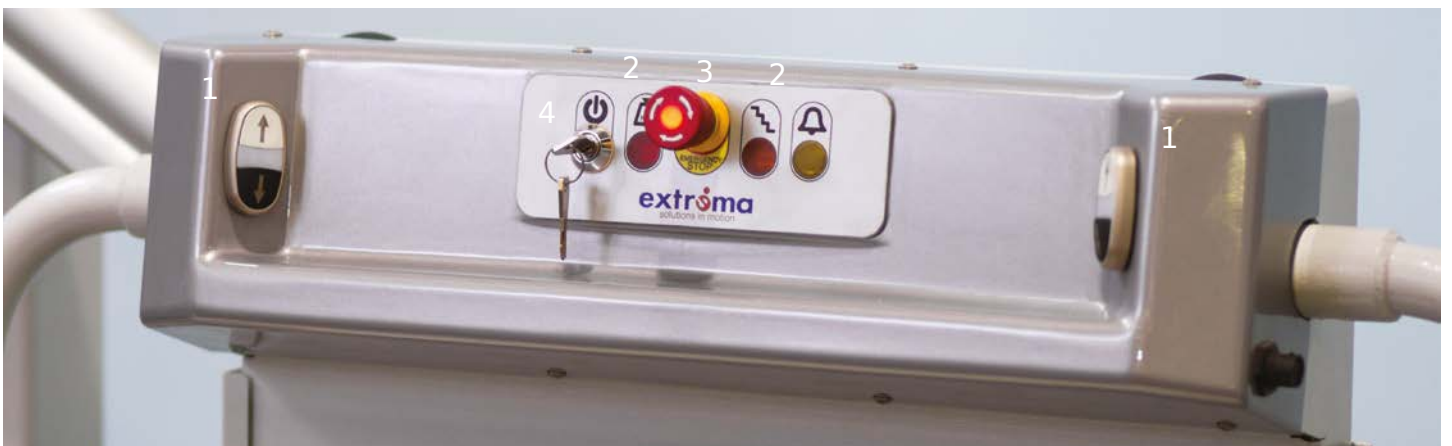
Hissi on kutsuttavissa ja lähetettävissä kauko-ohjaimella. Asiatoman käytön esto avaimella.
